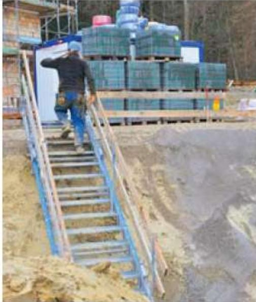
1 Accesso allo scavo tramite scala a gradini
