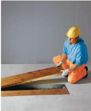
**Lavoratore:** se scopro delle aperture non protette nel pavimento, le metto in sicurezza con coperture resistenti alla rottura e solidamente fissate.
